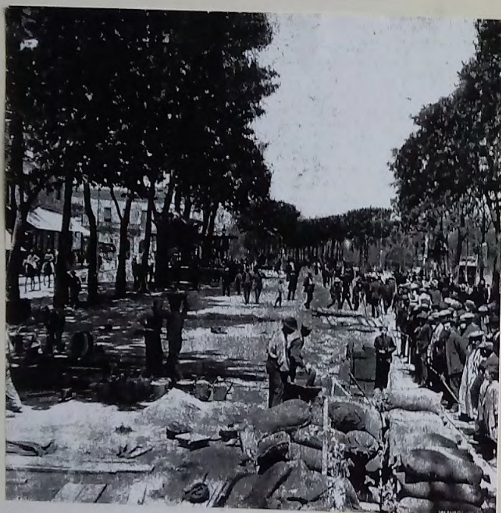
Pavimentació de la Rambla de Barcelona
