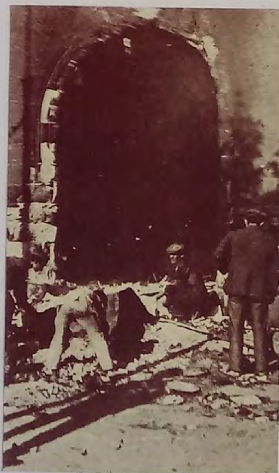
9 Als Escolapis de la Ronda de Sant Pau uns obrers busquen entre la runa.
