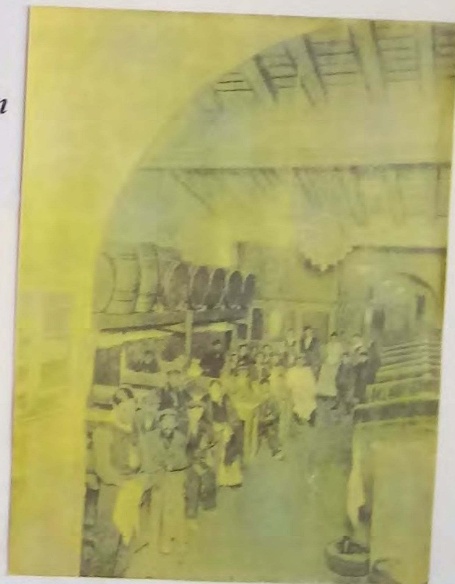
65 Bodega La Mina, al carrer Trenta-claus. Tenia també sortida pel carrer del Cid i per això era molt apreciada pels obrers anarquistes dels anys 10 i 20 sobre tot quan hi havia atacs policials.
