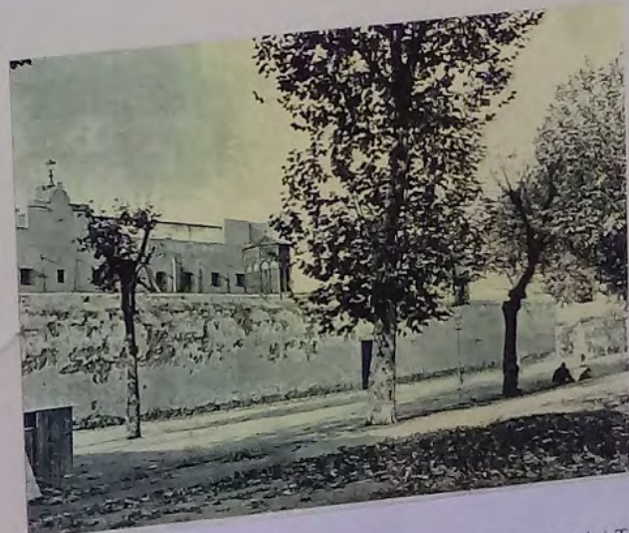
23 Presó de la Ronda Sant Pau (actualment plaça Folch i Torres) Convertida des de 1904 en presó de dones. En primer lloc el "Pati dels cordelers" a on al segle XIX es solien executar els condemnats
